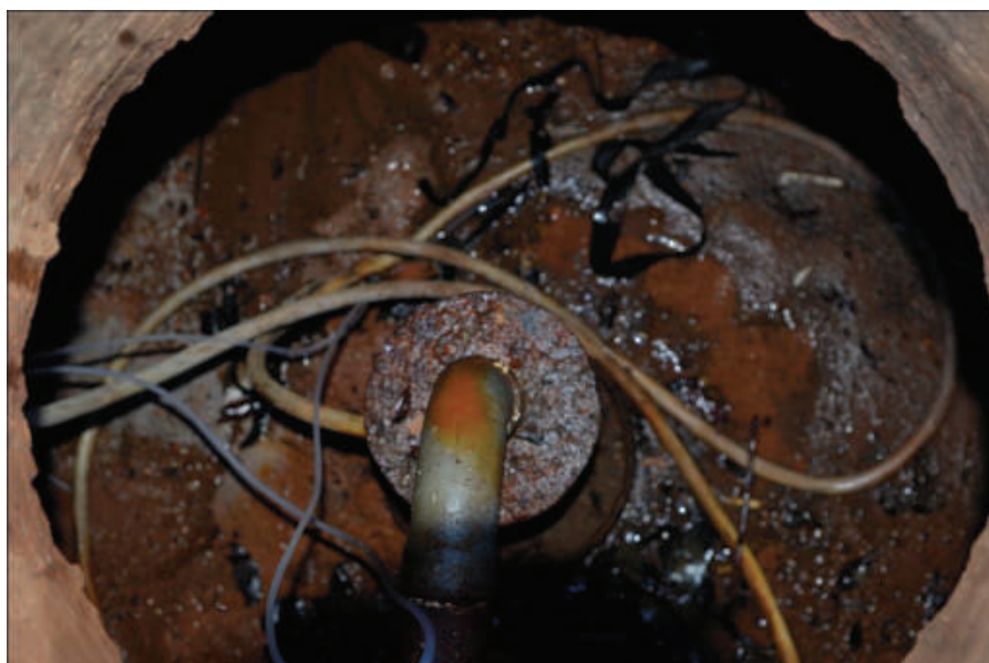
Foto 88: – Poço P3 Localização: Localização: São Lourenço.
