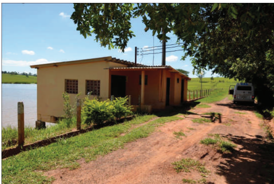
Foto 39: – Casa de Máquinas e Guarita Operador das Bombas ( Vista Lateral ) Localização: Barragem Santa Helena
