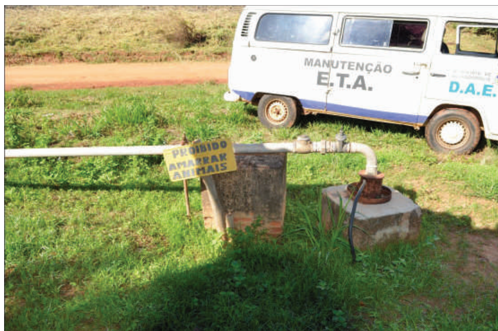
Foto 96: – Entrada do Poço – P7 Localização: – Bela Vista
