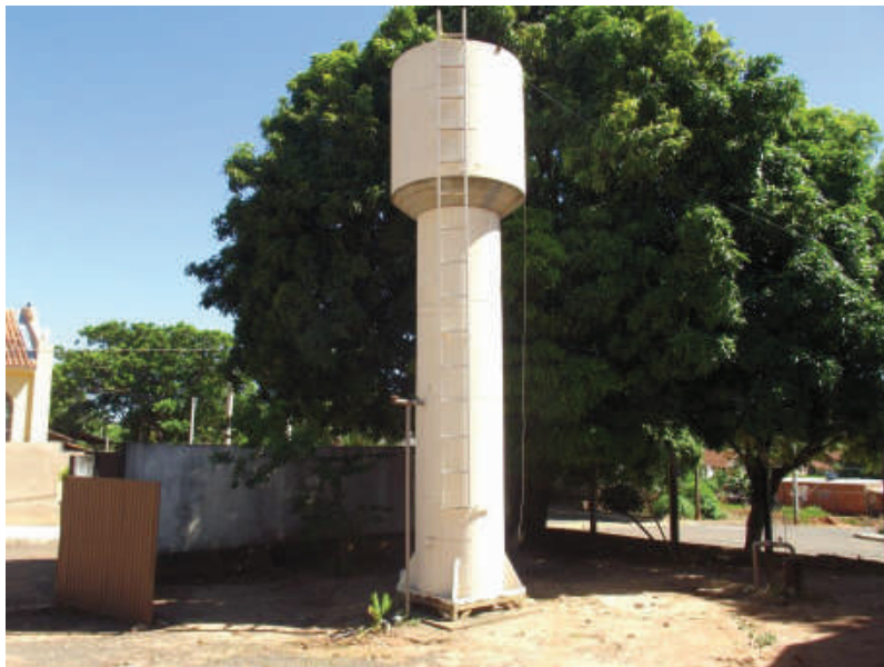
Foto 33: – Reservatório do Bairro Primeira Aliança - Capacidade: 10m 3 Localização: Av. João Francisco, nº 536
