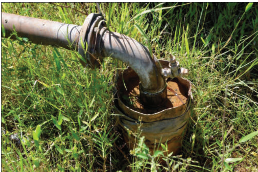
Foto 77: – Local onde se encontra Poço P1. Localização: Jardim Aeroporto.
