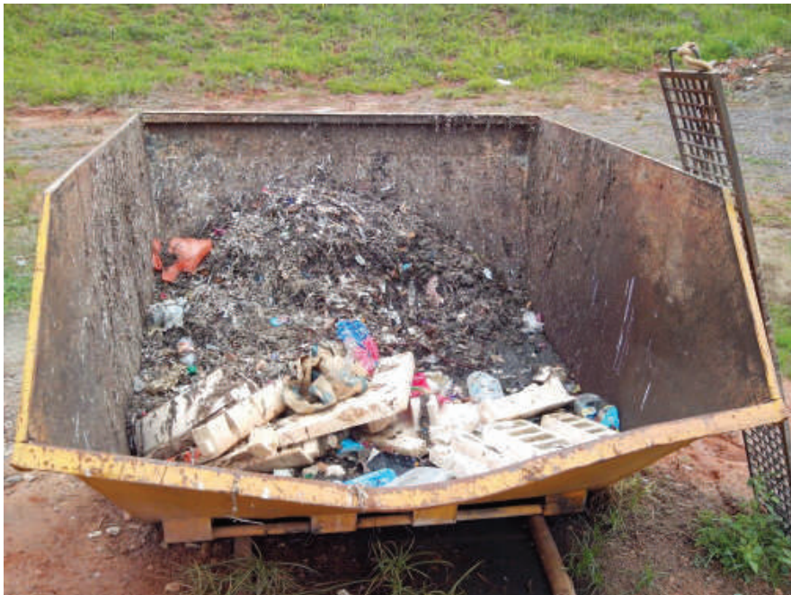
Foto 175: – Caçamba onde é Jogado os Dejetos do Gradeamento Localização: Estação Elevatória de Esgoto Ribeirão Conchal
