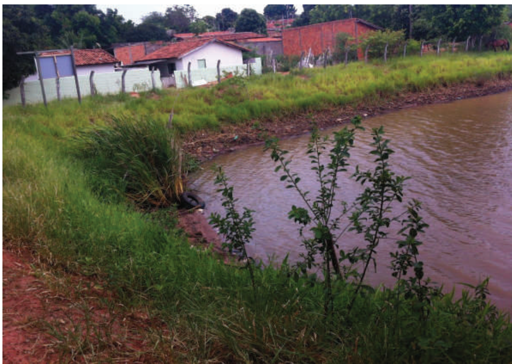
Foto 42: – Represa Santa Helena – Apresentando Baixo Nível de Reservação Localização: Barragem Santa Helena
