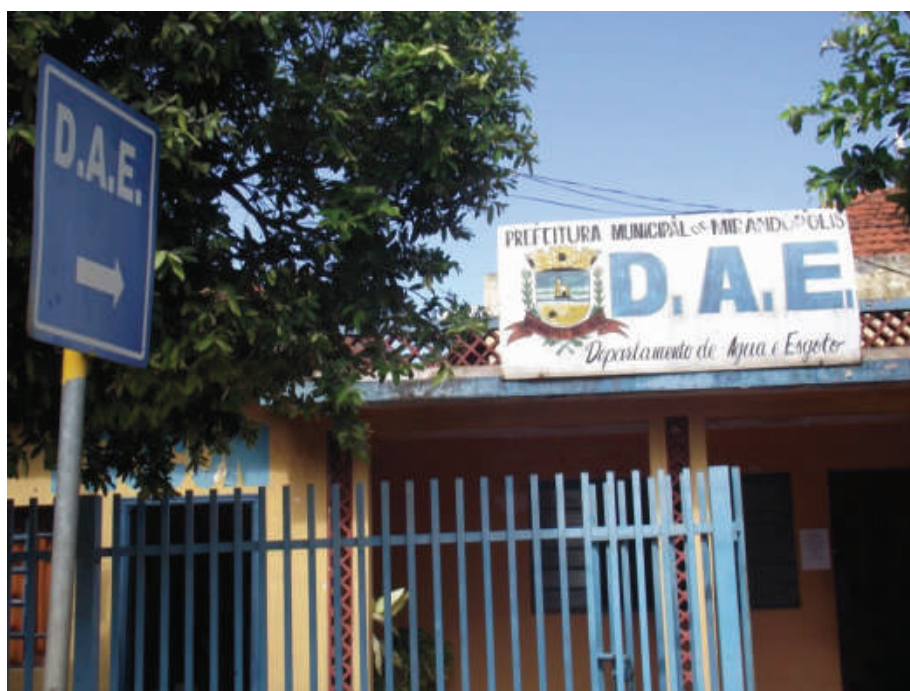
Foto 141: – Faixada da Entrada do SAAEM - Mirandópolis
