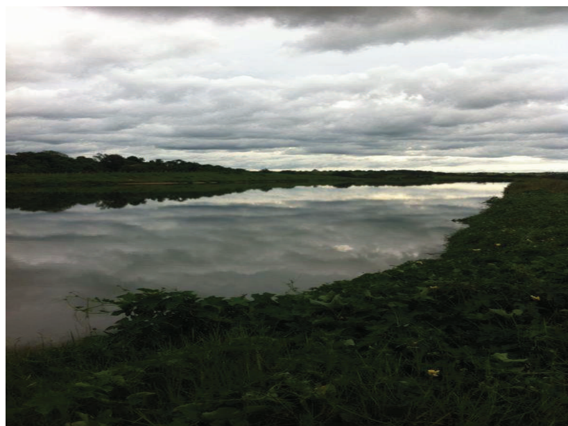
Foto: 188 – 1ª Lagoa de Tratamento de Esgoto (Vista Frontal)
