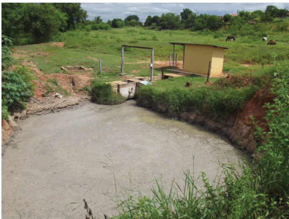
Foto 186: – Vala Executada pelo SAAEM para Conter os Constantes Extravasos de Esgotos (Vista Aérea)
