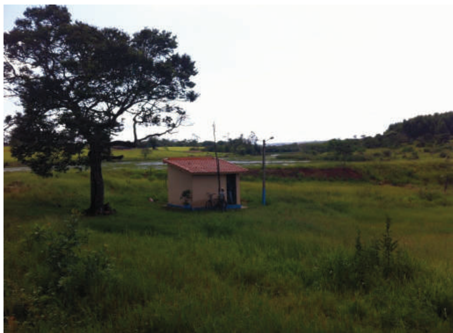
Foto 51: – Guarita Operadores Localização: Barragem São Lourenço
