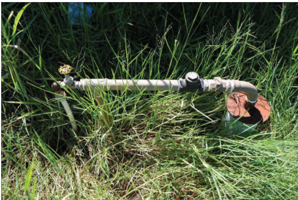
Foto 105: – Entrada do Poço (P9) Localização: – Colina Verde
