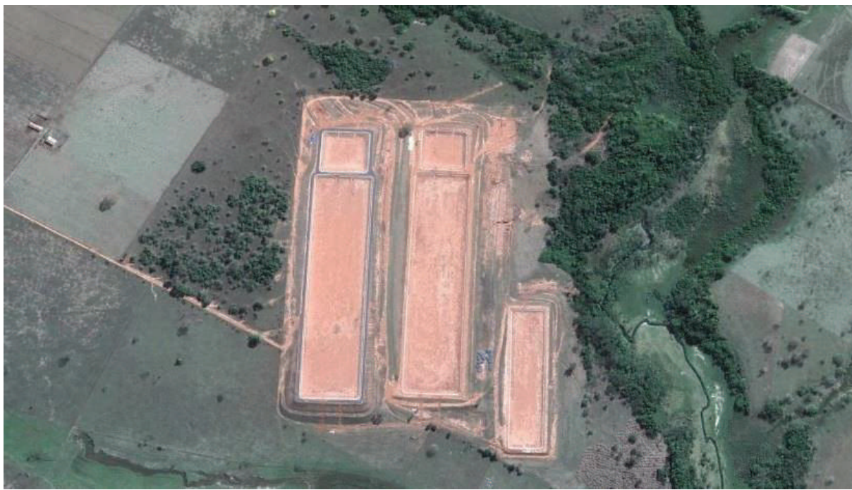
Foto 168: – Imagem Satélite da Estação Elevatória de Esgoto Ribeirão Conchal Fase de Término onde hoje esta ETE já esta totalmente Cheia
