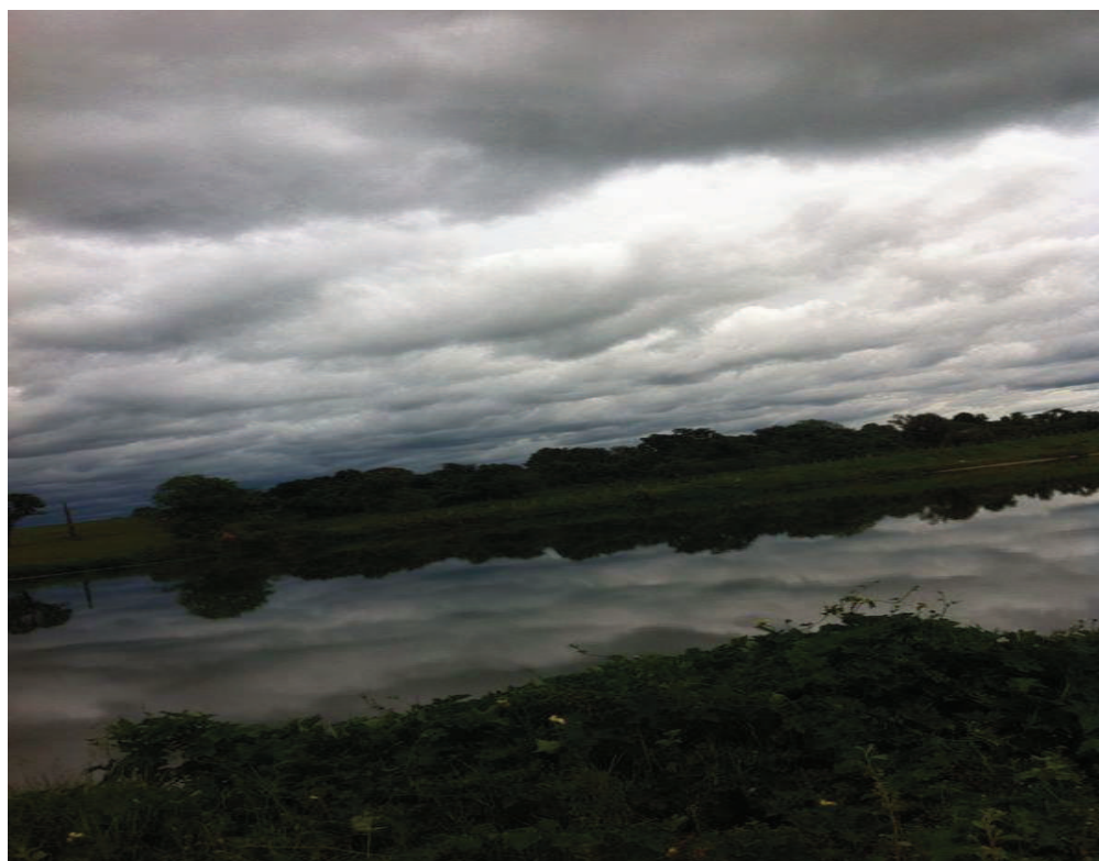
Foto: 190 – 1ª Lagoa de Tratamento de Esgoto (Vista Parcial) Localização: ETE – Estação de Tratamento de Esgoto de Mirandópolis
