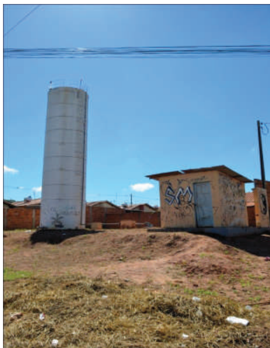
Foto 30: – Reservatório CDHU / Sonho Meu - Capacidade: 100m 3 Localização: Rua Adeja Vieira Faria, s/nº
