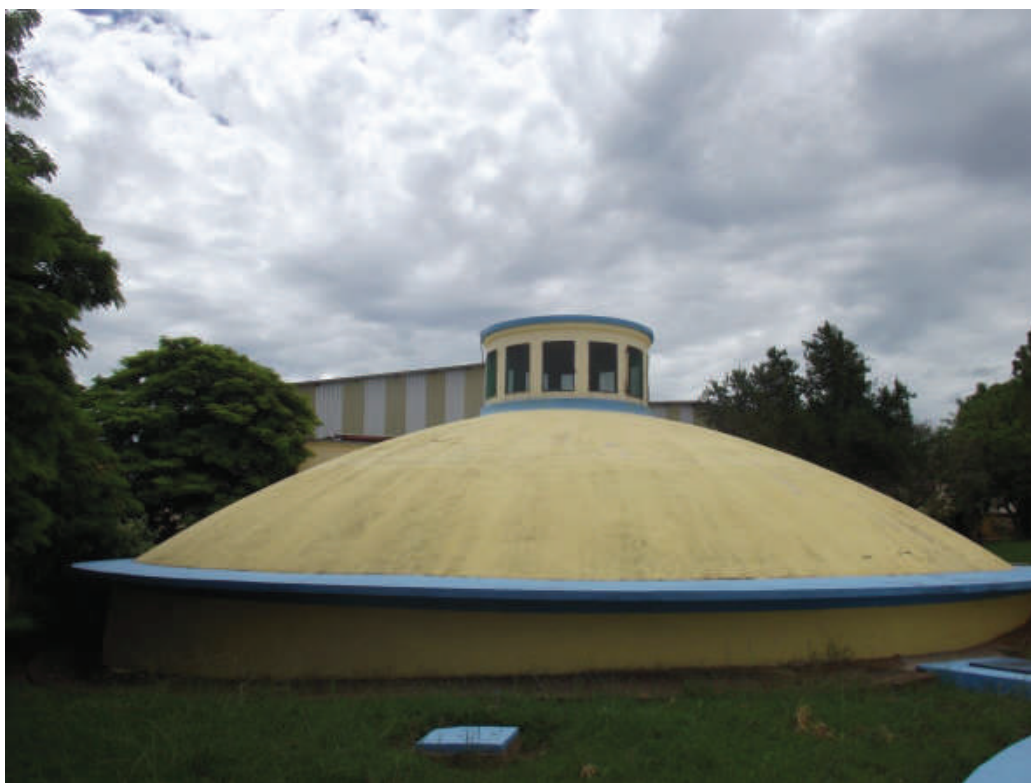
Foto 19: – Reservatório Semi – Enterrado II – ETA – Capacidade de 800m 3 Localização: Rua Ana Luiza da Conceição, nº 510
