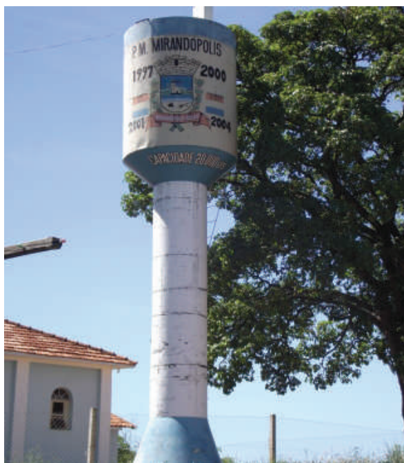
Foto 35: – Reservatório do Bairro Segunda Aliança / Igreja - Capacidade: 20m 3
