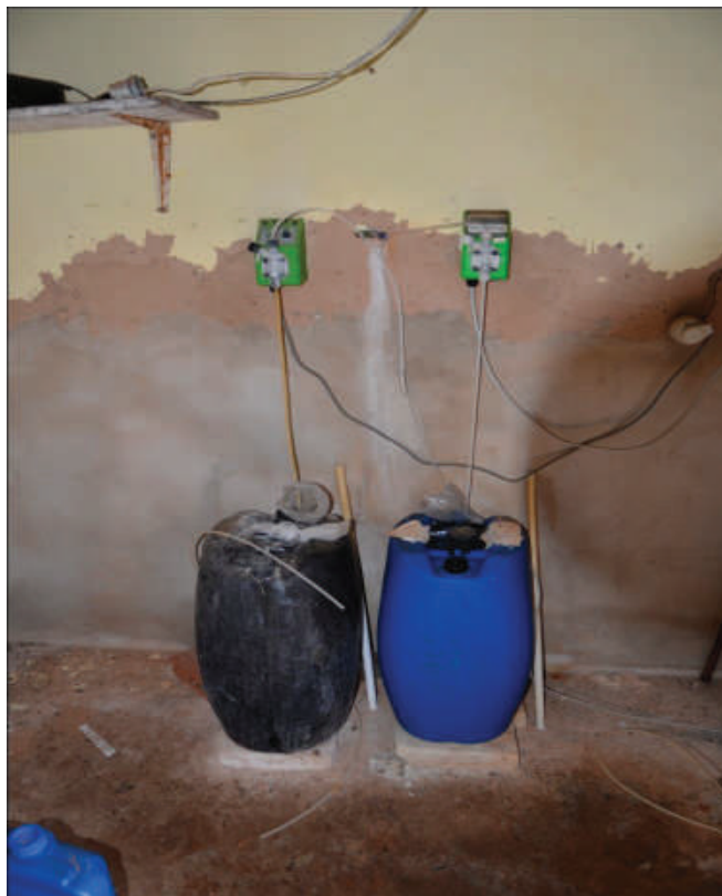
Foto 126: – Bombas Dosadoras e Produtos Químicos para Tratamento - Poço P1 e P2 Localização: Bairro Amandaba
