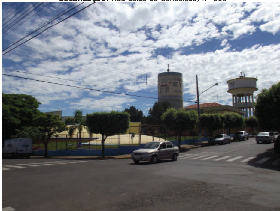
Foto 58: – ETA – Estação de Tratamento de Água Localização: Rua Luiza da Conceição, nº 510
