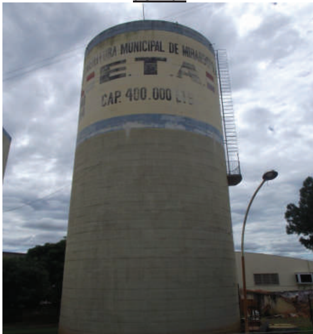
Foto 15: – Reservatório Elevado - ETA – Capacidade de 400m 3 Localização: Rua Ana Luiza da Conceição, nº 510
