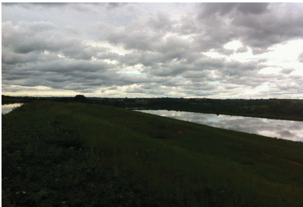
Foto: 192 – 2ª Lagoa de Tratamento de Esgoto (Vista Lateral) Localização: ETE – Estação de Tratamento de Esgoto de Mirandópolis
