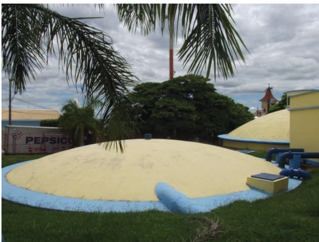
Foto 18: – Reservatório Semi – Enterrado I – ETA – Capacidade de 1.000m 3 Localização: Rua Ana Luiza da Conceição, nº 510
