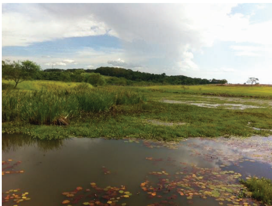
Foto 55: – Represa São Lourenço – Apresentando Assoreamento Localização: Barragem São Lourenço
