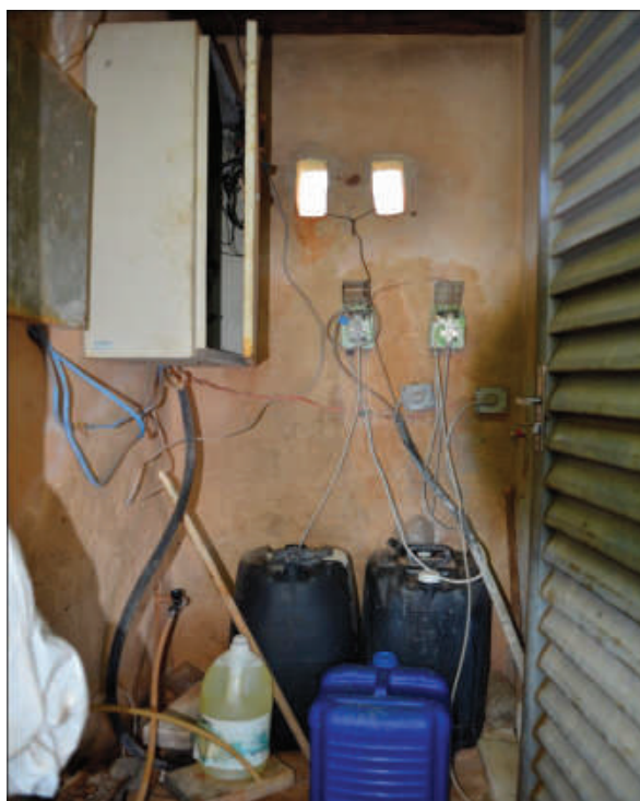
Foto 89: – Painel Elétrico, Bombas Dosadoras e Produtos Químicos – Poço P3 Localização: Localização: São Lourenço.
