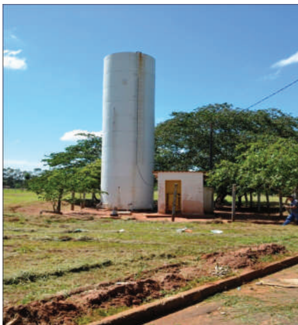
Foto 27: – Reservatório Morada do Sol – Capacidade: 100m 3 Localização: Rua Miguel Camacho, s/nº
