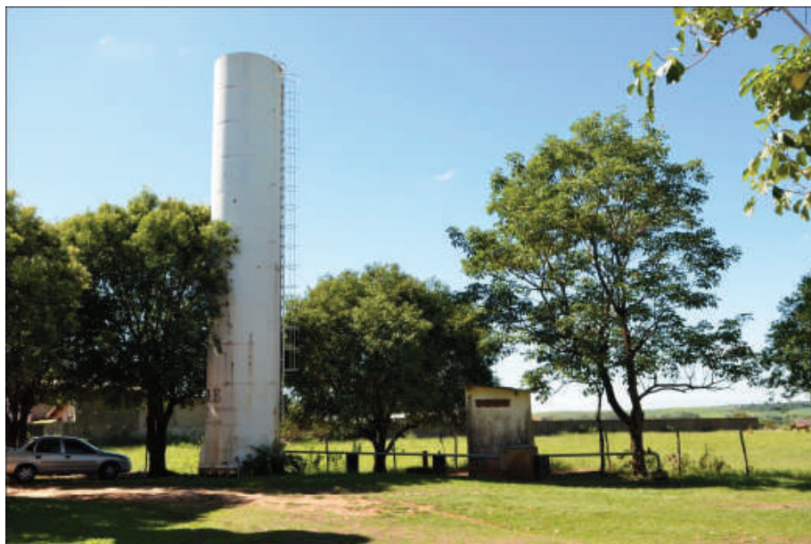
Foto 83: – Poço Profundo – P2 – Casa Painel Elétrico e Reservatório Localização: Casa da Criança.
