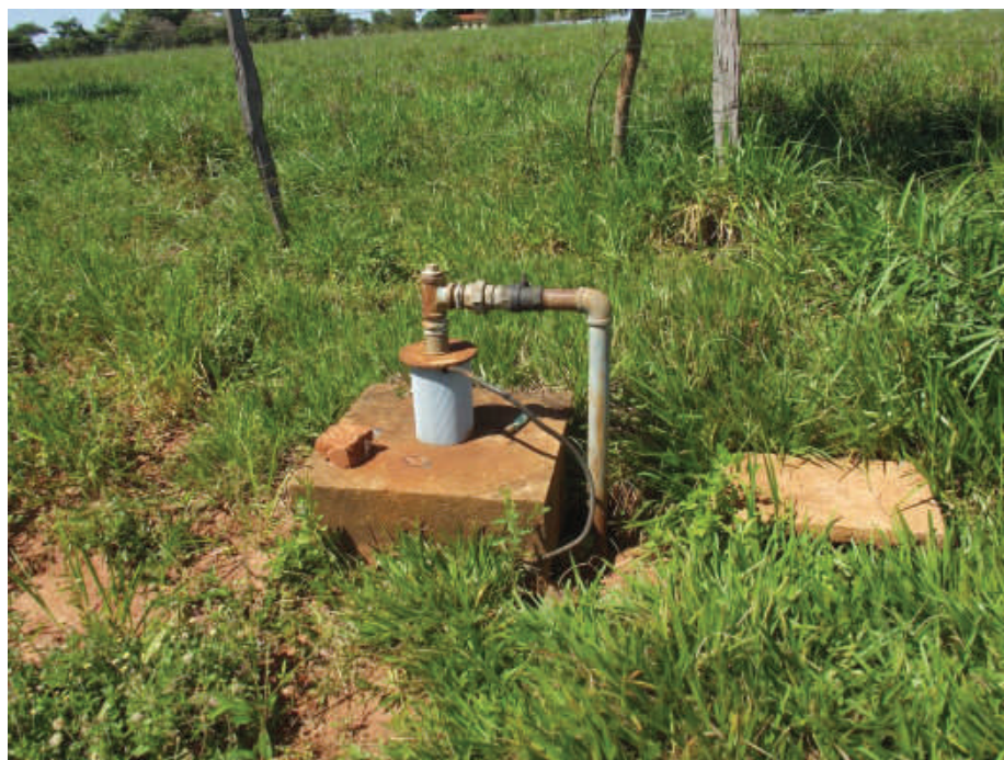
Foto 135: – Entrado do Poço – P1 Localização: Bairro Terceira Aliança
