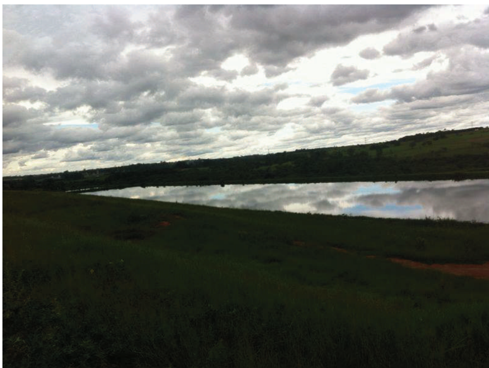
Foto: 189 – 1ª Lagoa de Tratamento de Esgoto (Vista Lateral) Localização: ETE – Estação de Tratamento de Esgoto de Mirandópolis
