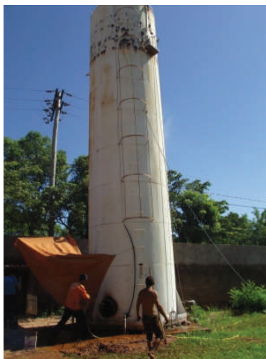
Foto 28: – Reservatório Jardim Ipê (Sunada- Antiga Delegacia) - Capacidade: 70m 3 Localização: Rua Antônio Simões Pessoa, nº 35
