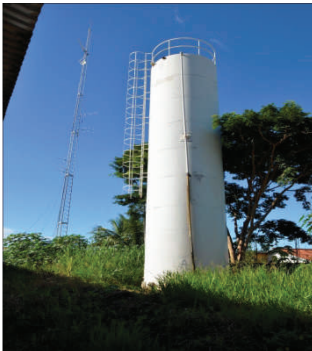
Foto 21: – Reservatório São Lourenço – Capacidade de 50m 3 Localização: Rua Senador Rodolfo Miranda, nº 297
