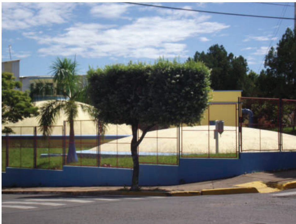
Foto 57: – ETA – Estação de Tratamento de Água Localização: Rua Luiza da Conceição, nº 510
