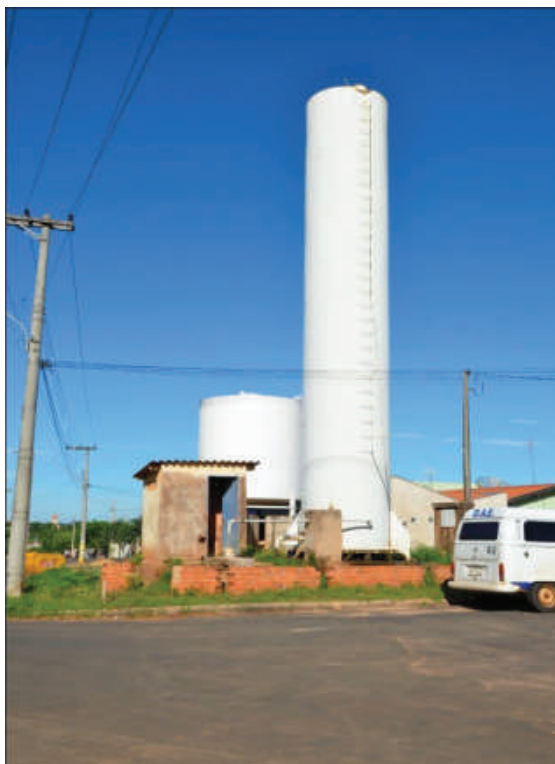
Foto 23: – Reservatório Conjunto Habitacional Agostinho Franco ( Bairros Cohab e Ana Maria ) Capacidade 50m 3 Localização: Rua Luiz Pilla, nº 1616
