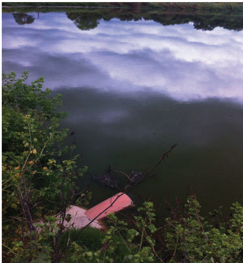
Foto: 197 – Tubulação de Passagem de uma Lagoa para Outra Localização: ETE – Estação de Tratamento de Esgoto de Mirandópolis
