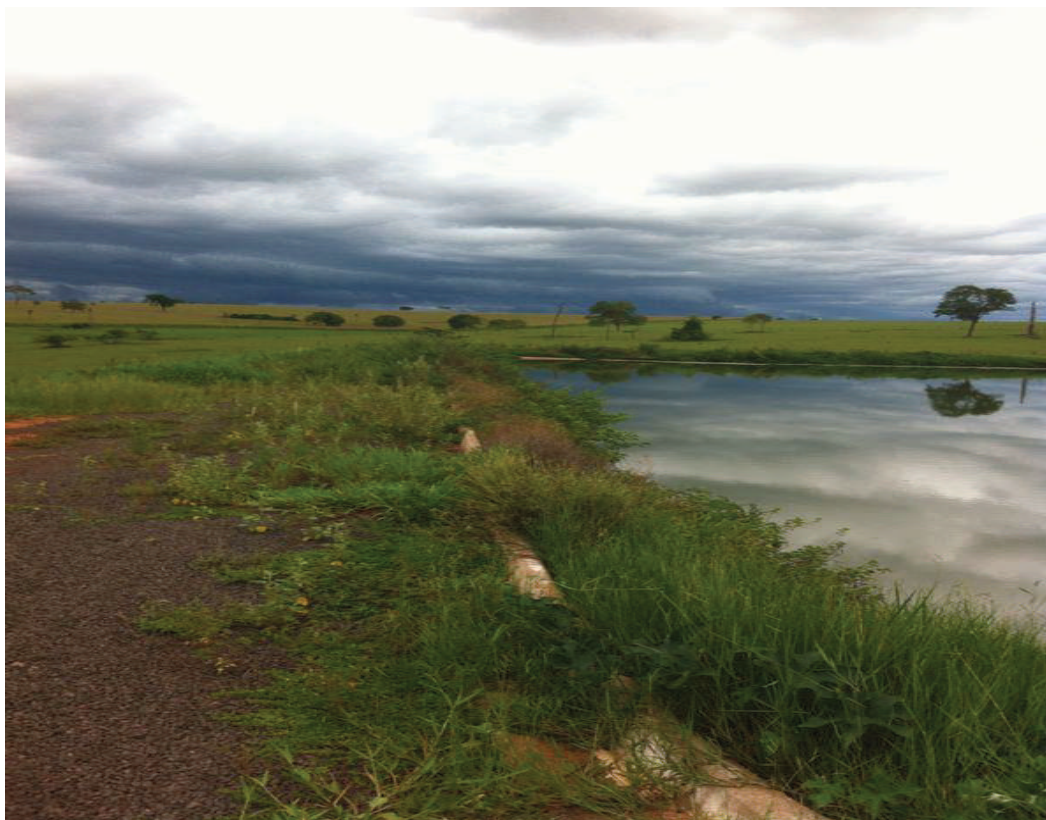
Foto: 191 – 2ª Lagoa de Tratamento de Esgoto (Vista Parcial) Localização: ETE – Estação de Tratamento de Esgoto de Mirandópolis
