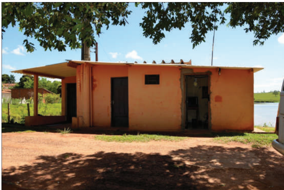
Foto 40: – Casa de Máquinas e Guarita Operador das Bombas ( Vista Frontal ) Localização: Barragem Santa Helena
