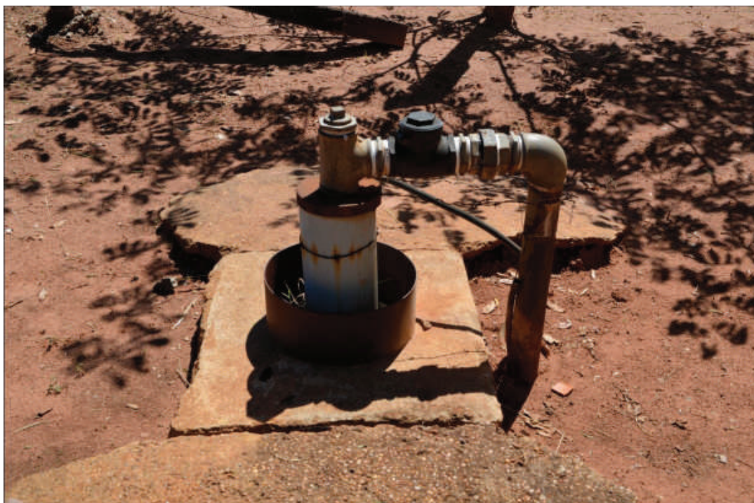
Foto 108: – Entrada do Poço P10 Localização: Morada do Sol
