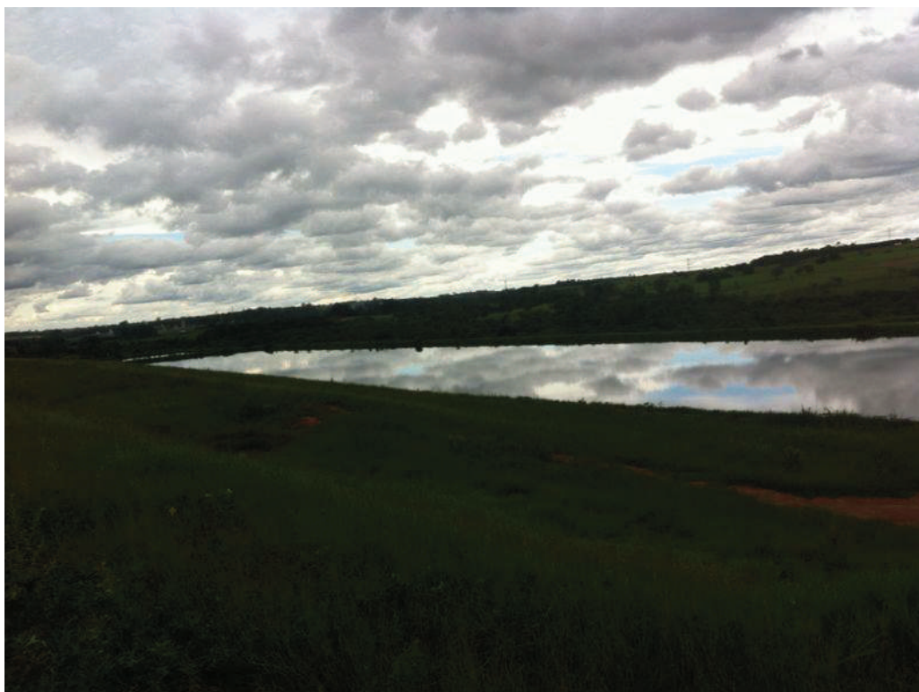
Foto: 194 – 2ª Lagoa de Tratamento de Esgoto (Vista Lateral) Localização: ETE – Estação de Tratamento de Esgoto de Mirandópolis
