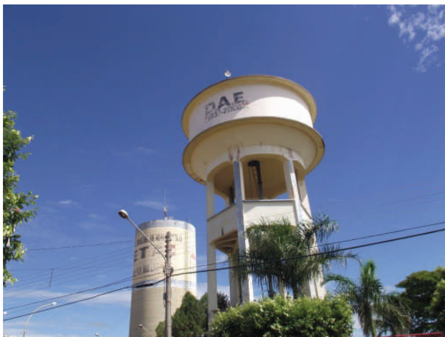
Foto 17: – Reservatórios Elevados – ETA – Juntos Capacidade de 600m 3 Localização: Rua Ana Luiza da Conceição, nº 510
