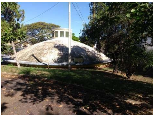
Figura 61. Vista geral do reservatório RSE 02
