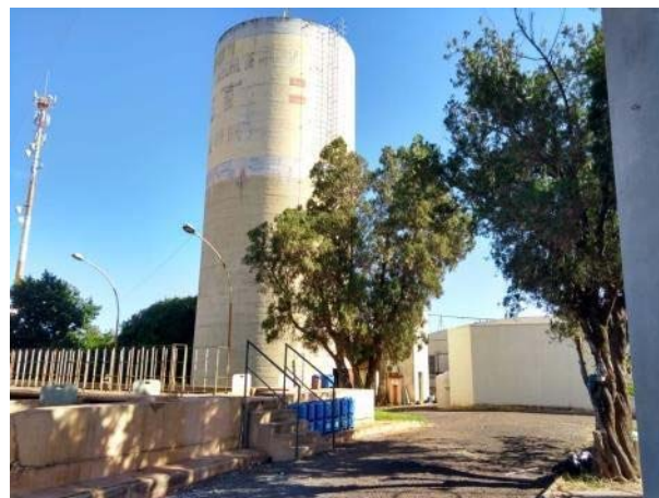
Figura 62. Vista geral do REL 02
