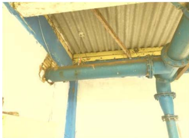
Figura 22. Vista geral do macromedidor de inserção da Cap. São Lourenço
