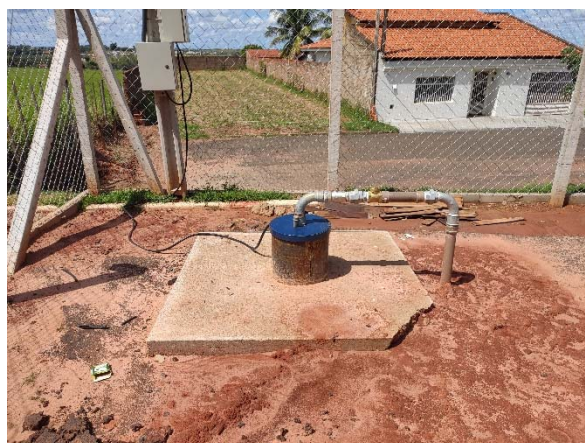
Figura 181. Vista do P26 em implantação
