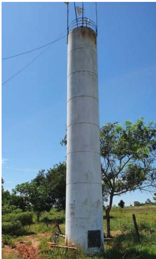
Figura 207. Vista geral do RAP – 15
