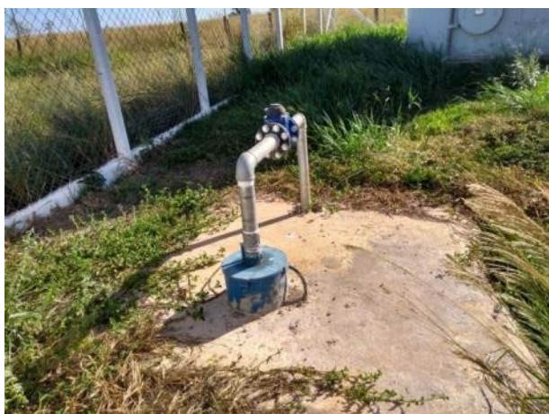
Figura 146. Vista geral do poço P13
