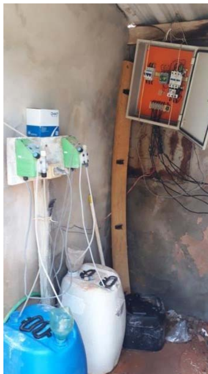
Figura 104. Vista geral da casa de química
