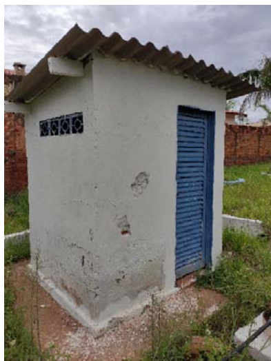
Figura 164. Vista geral do P16 e casa de química
