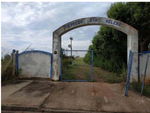
Figura 28. Vista geral da entrada da Captação Santa Helena
