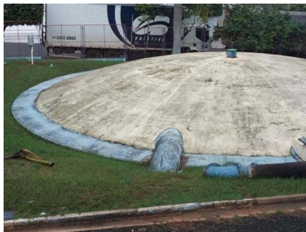
Figura 58. Vista geral do reservatório RSE 01
