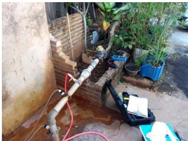
Figura 120. Vista geral do poço P09
