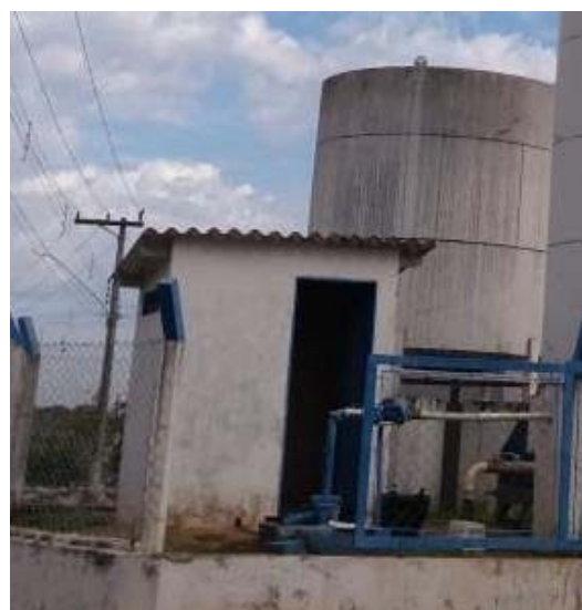
Figura 88. Vista da casa de química
