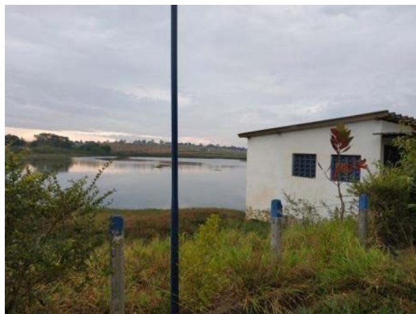
Figura 31. Vista geral represa Santa Helena e casa de bombas
