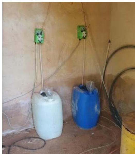
Figura 200. Vista geral da casa de química.
