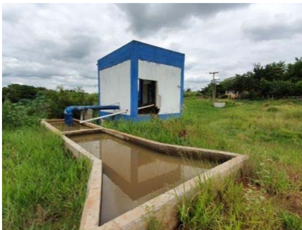
Figura 17. Vista geral do poço de sucção da Cap. São Lourenço
