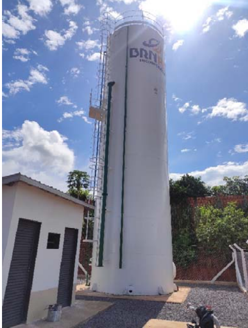
Figura 185. Vista do RAP-16 em implantação
