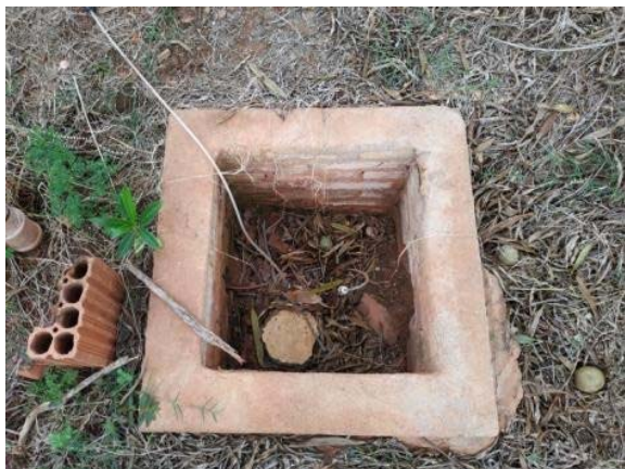
Figura 153. Vista geral da aplicação de polímeros do P14
