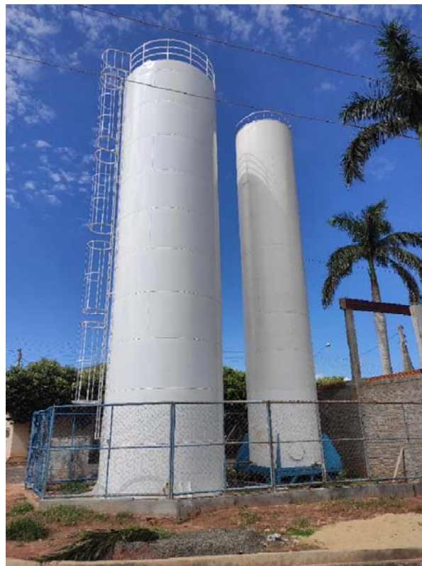
Figura 167. Vista geral do novo RAP-13
