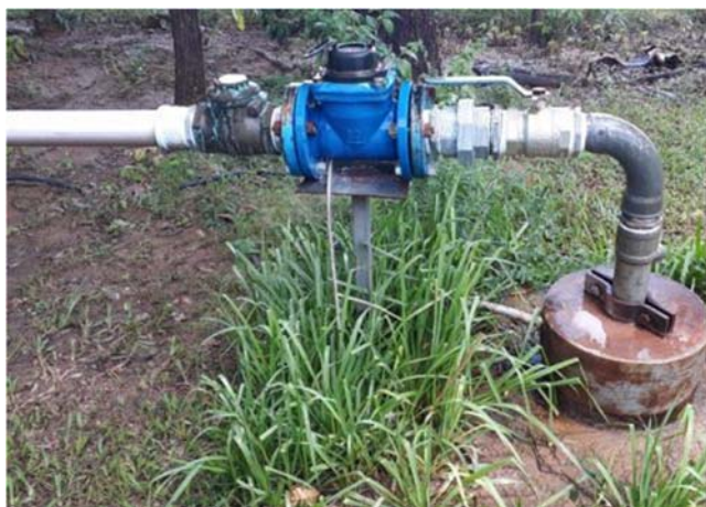
Figura 73. Vista geral do poço P02
