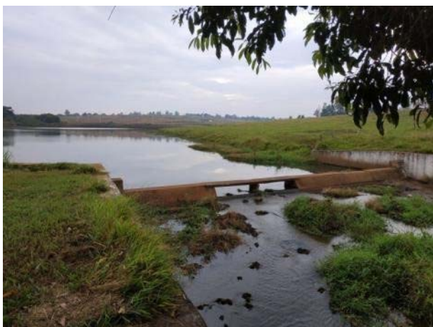
Figura 34. Vista geral do extravasor da represa Santa Helena
