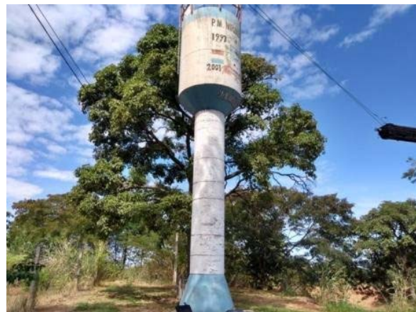
Figura 198. Vista geral do REL 05
