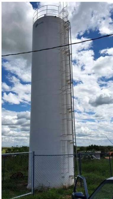
Figura 141. Vista geral do RAP-10
