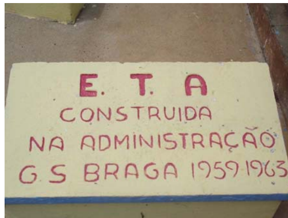
Figura 66. Placa Mostrando o Ano de Construção da ETA
