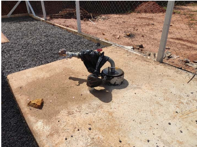
Figura 186. Vista do P27 em implantação
