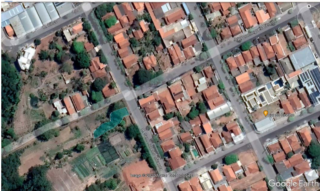
Figura 233: Ponto de erosão na Rua Senador Rodolfo Miranda (Google Earth)
