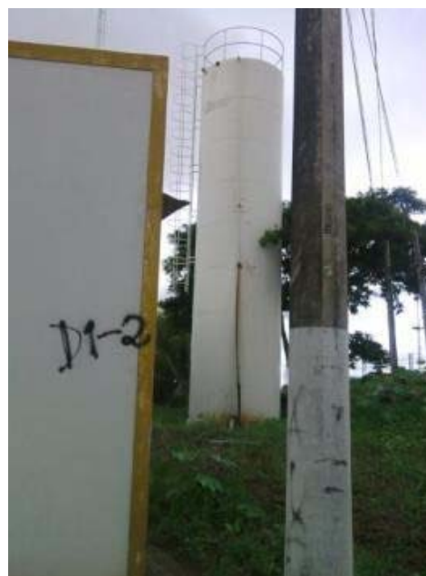
figura 169. Vista geral do RAP-14
