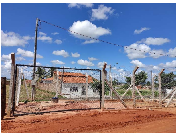
Figura 180. Vista geral da área do poço
