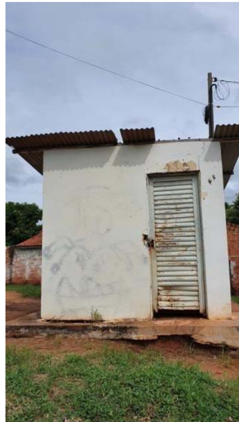
Figura 117. Vista geral da casa de química
