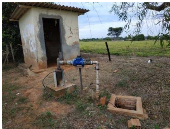
Figura 151. Vista geral do local do P14
