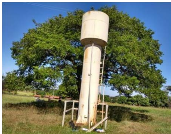
Figura 203. Vista geral do REL - 06
