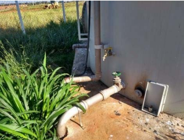
Figura 148. Vista geral entrada e saída do RAP-11
