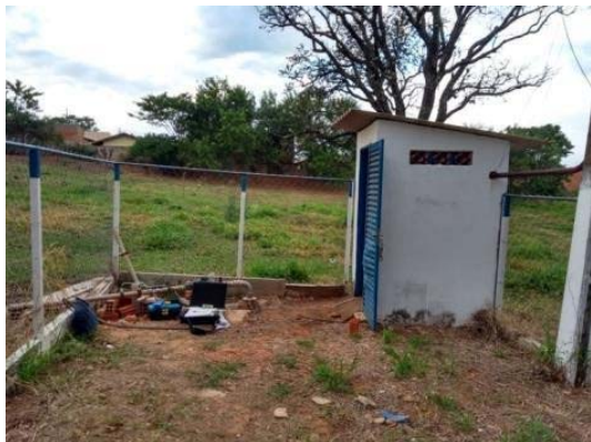
Figura 89. Vista geral do Poço P04
