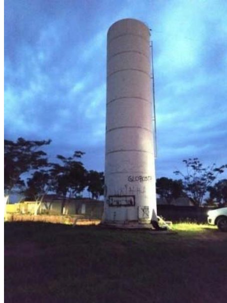
Figura 99. Vista geral do RAP - 03
