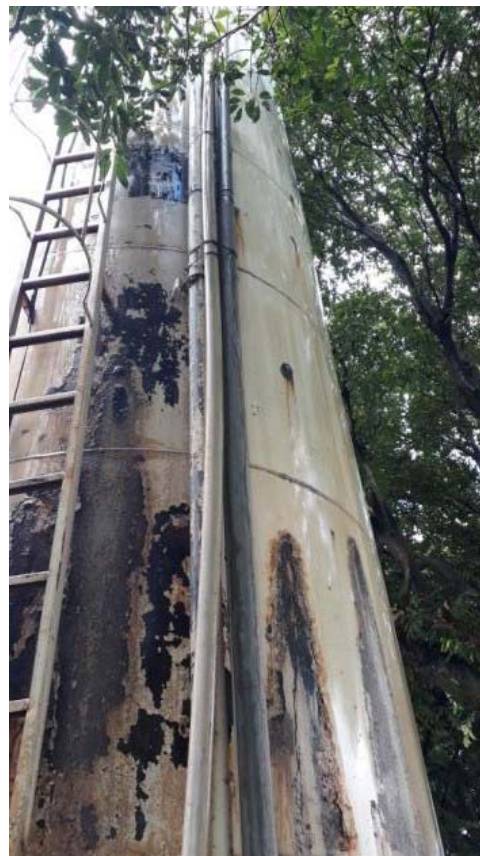
Figura 80. Vista geral das tubulações do reservatório RAP-01
