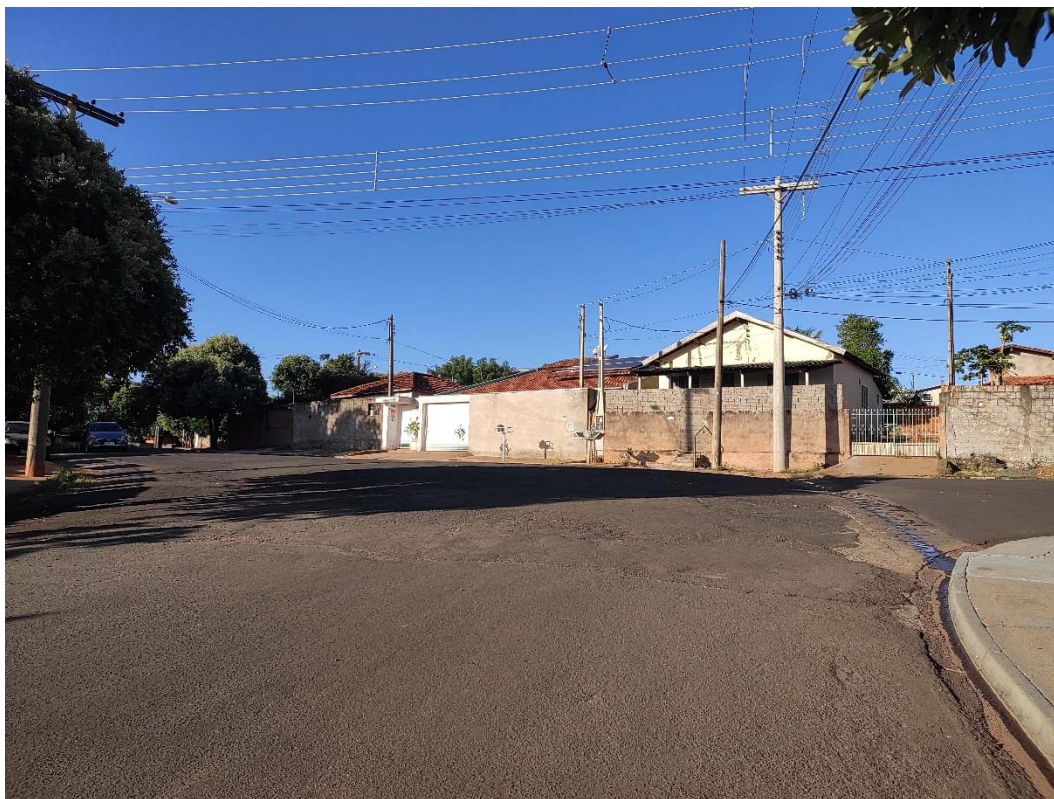
Figura 223: Ponto de alagamento entre Rua Deusdete Leite de Almeida x Rua Domingos Mathias.
