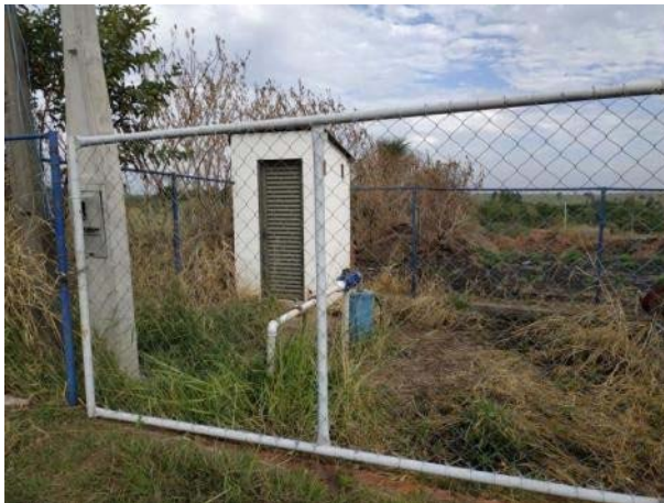
Figura 138. Vista geral do poço P12
