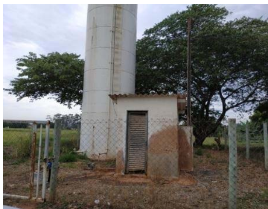
Figura 107. Vista externa da casa de química
