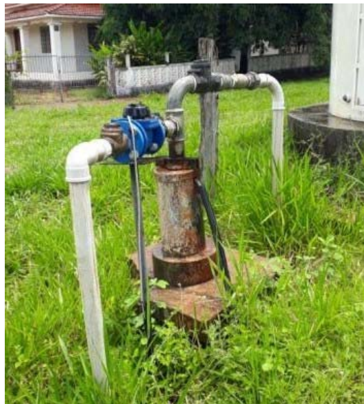
Figura 133. Vista geral do poço P11
