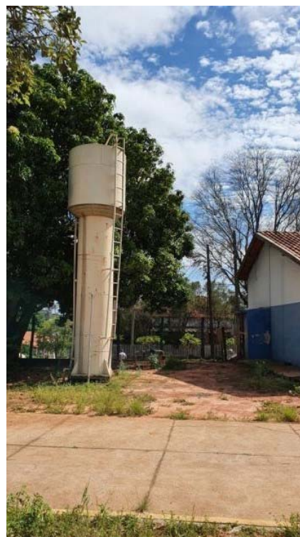
Figura 192. Vista geral do REL 04
