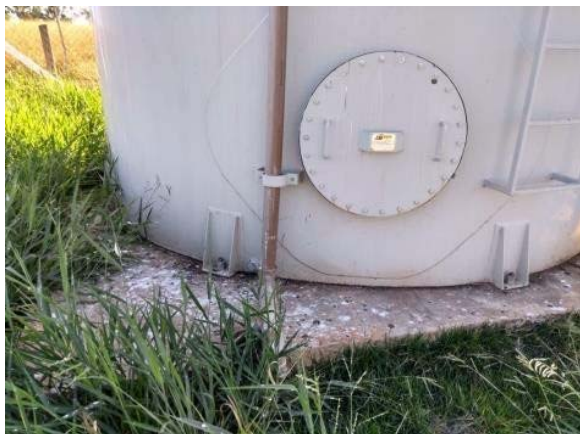
Figura 149. Vista da boca de visita do RAP – 11
