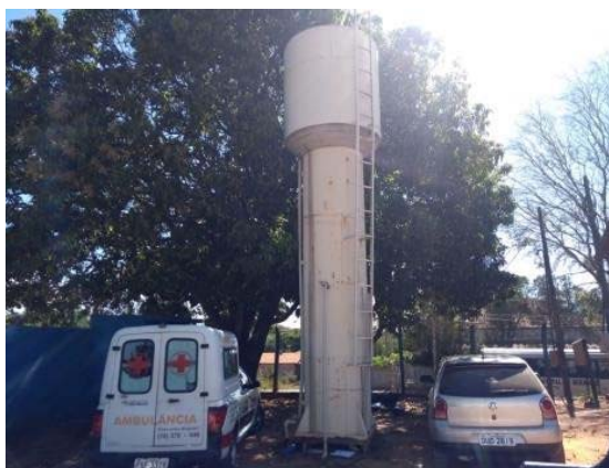
Figura 191. Vista geral do P18 e REL 04
