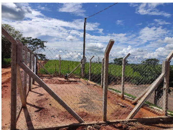
Figura 182. Vista geral do alambrado do poço
