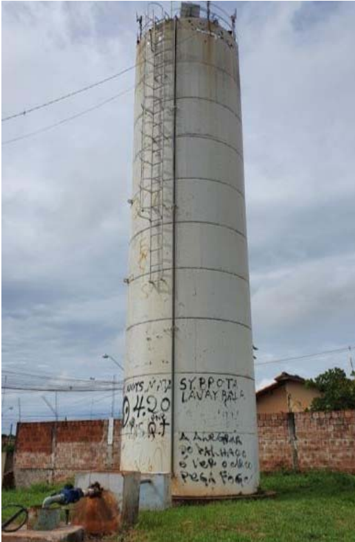
Figura 116. Vista geral do RAP -06.
