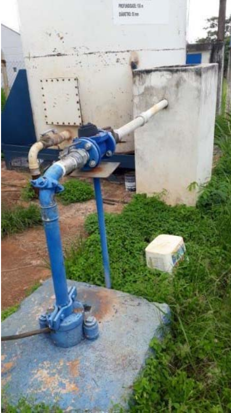
Figura 83. Vista geral do poço P03
