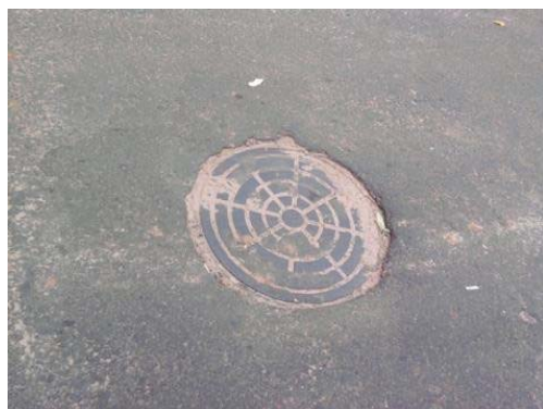
Figura 168. Vista geral do tampão do poço P17
