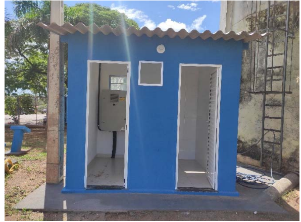
Figura 177. Vista geral da nova casa de dosagem
