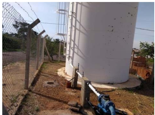
Figura 129. Vista geral do poço P10 e RAP-08
