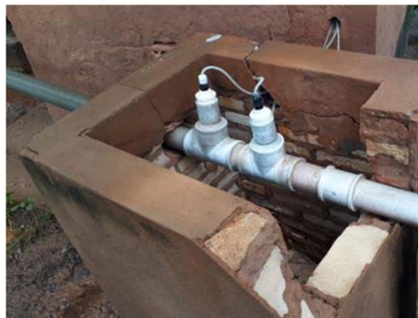
Figura 74. Vista do tratamento no P02
