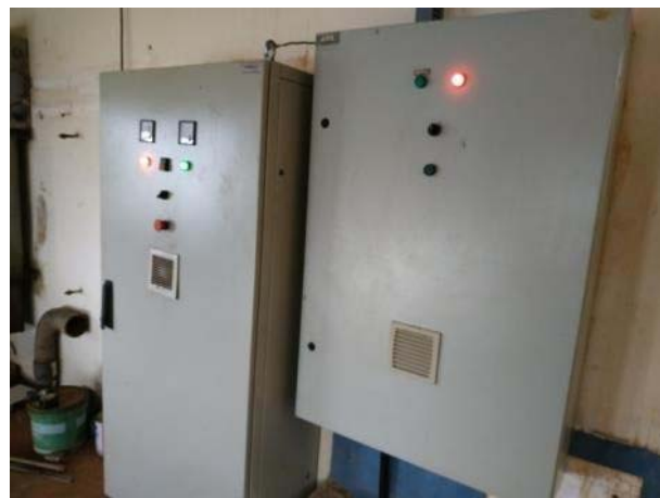
Figura 41. Vista externa dos painéis da captação Santa Helena
