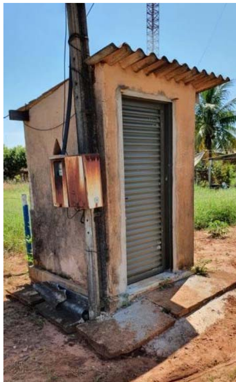
Figura 208. Vista geral da casa de química
