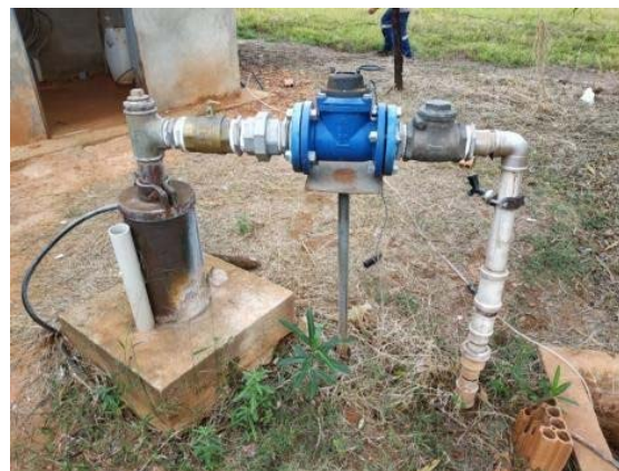
Figura 152. Vista geral do poço P14
