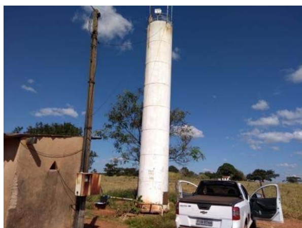
Figura 205. Vista geral do P21 e RAP 15
