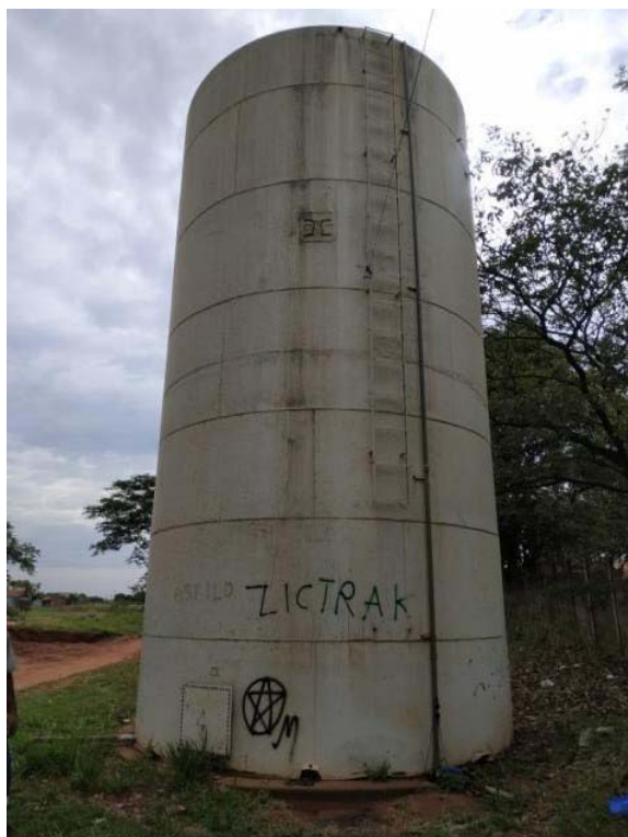
Figura 105. Vista geral do RAP -04
