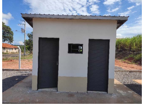
Figura 187. Vista geral da casa de dosagem
