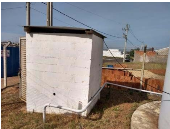
Figura 127. Vista geral da casa de química
