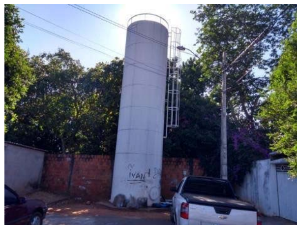
Figura 123. Vista geral do RAP -07
