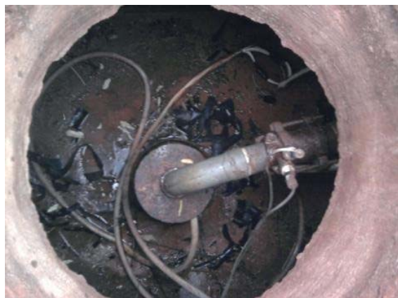
Figura 170. Vista geral do poço P17
