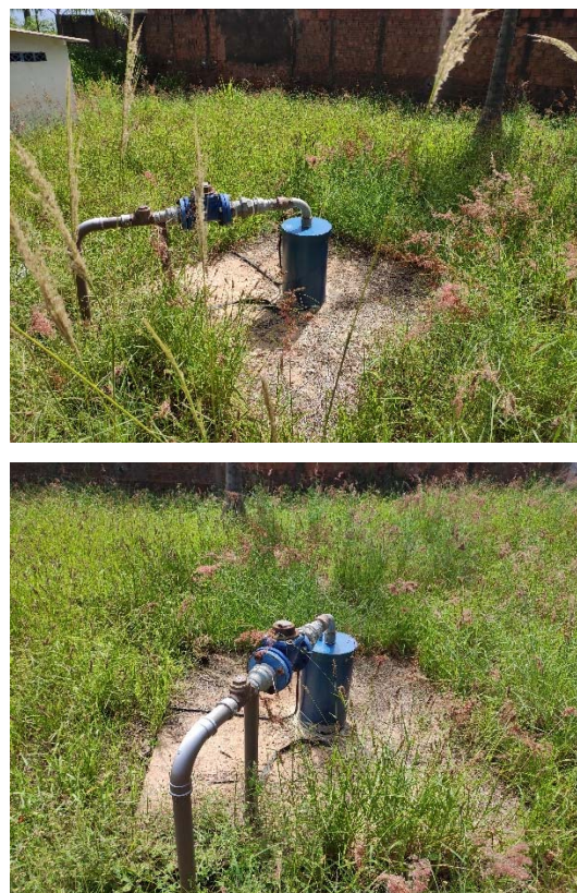
Figura 165 Vista geral do novo Poço P16
