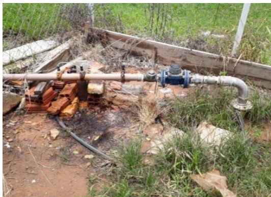
Figura 93. Vista geral do macromedidor do Poço P04
