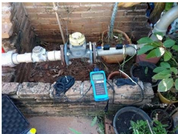
Figura 122. Vista do poço P09
