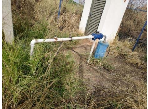
Figura 140. Vista do macromedidor do poço P12
