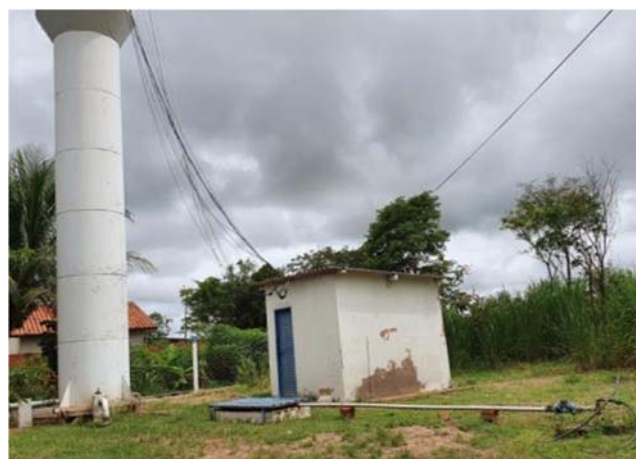
Figura 212. Vista geral do P22 e REL-07
