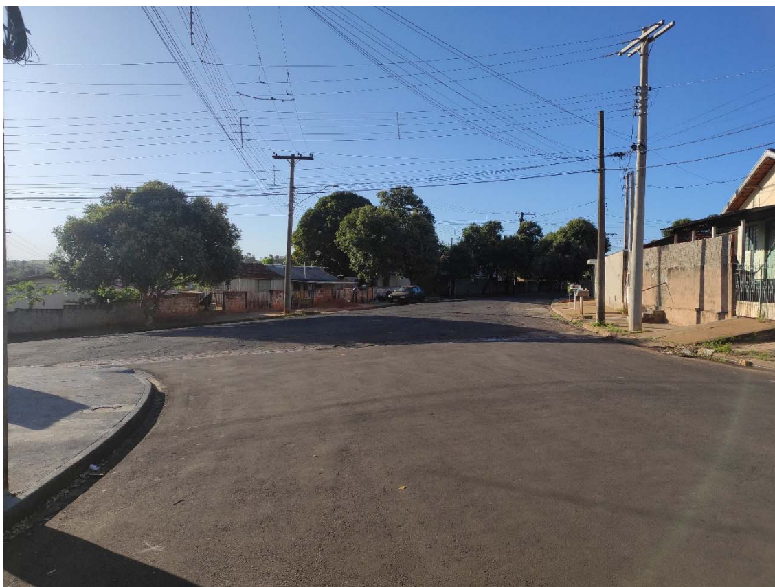
Figura 224: Ponto de alagamento entre Rua Deusdete Leite de Almeida x Rua Domingos Mathias, outro ângulo.
