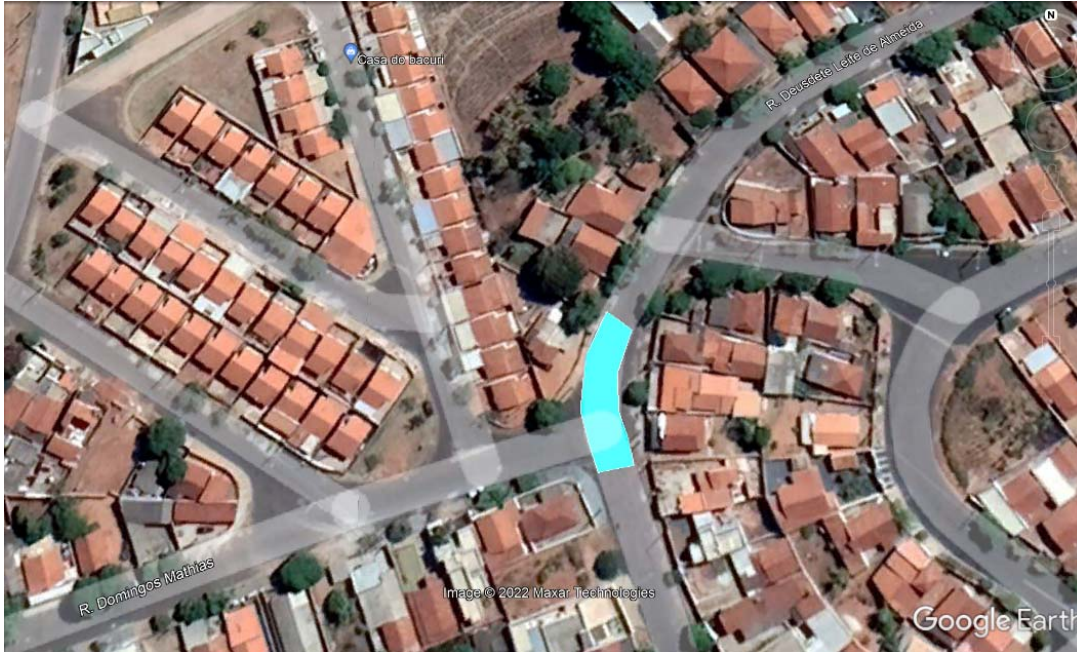
Figura 222: Ponto de alagamento entre Rua Deusdete Leite de Almeida x Rua Domingos Mathias (Google Earth).
